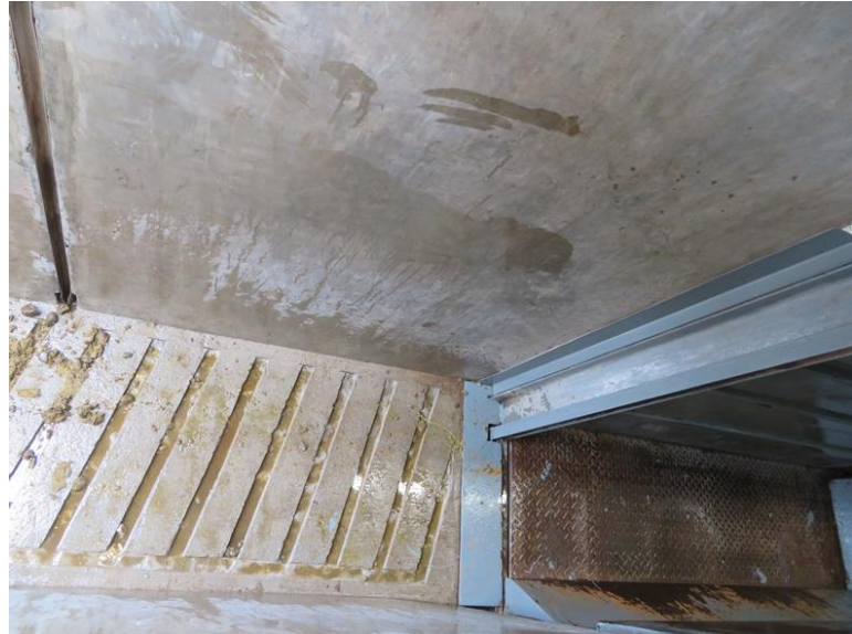
Figure 2 : La transition entre le passage et le box d'abattage contient une bande métallique grise transversale qui fait s'arrêter les chevaux à leur montée.
