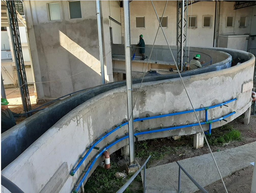
Figuur 8: Licht oplopende S-vormige drijfgang naar de fixatiebox.
