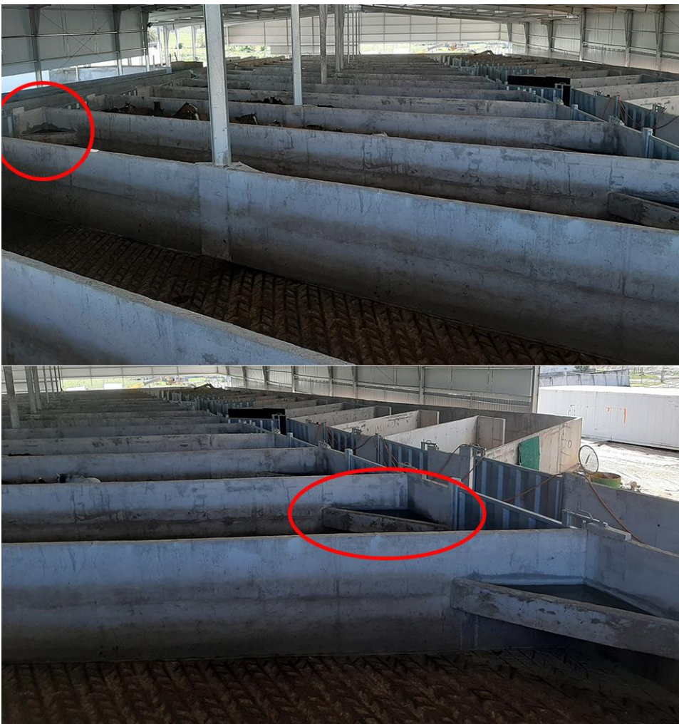
Figuur 6: Een visgraatvormige wachtstal en hoge egale dichte zijwanden in de drijfgangen.
