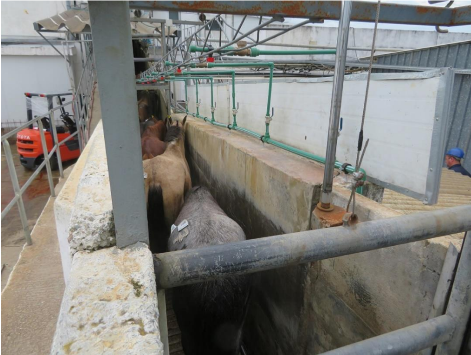
Figuur 5: Douche die traag opstart en fijne neveldruppels geeft, waardoor dit minder stresserend is voor de paarden.
