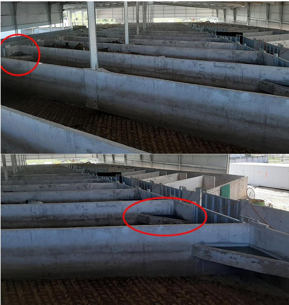
*Figura 6: Stalla di sosta a lisca di pesce con pareti laterali alte e di uguale spessore nei passaggi.*
